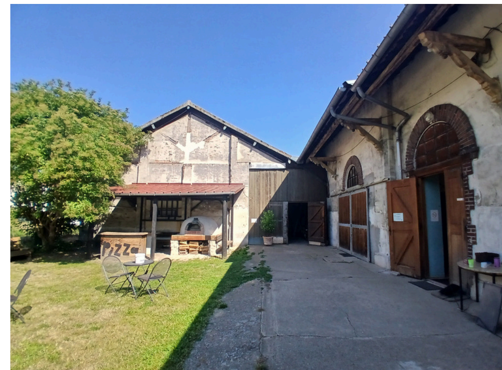
ESPACE 2: dégustation prêt d'un bâti. Exemple avec la Ferme du Saut du Loup, lieu de la première en mai 26.
